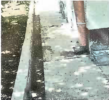
Foto 5: Modulo 2: Reparación de bajada de agua pluvial, tubo PVC 3"
