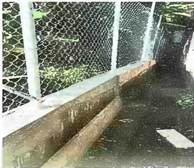
Foto 9: Módulo 3: Reparación de cuneta de concreto
