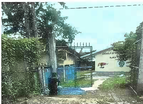
Foto 11: Portón de Ingreso
