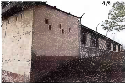
Foto 3: Modulo 1: Pintura en muros exteriores e interiores
