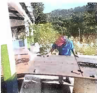
Foto 5: Modulo 1: Mantenimiento a estructura de puerta (lijado, cambio de tubo, cepillado, sujeciones, aplicación de pintura)
