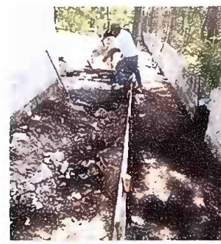
Foto 2: Modulo 1: Reparación de banquetas de concreto
