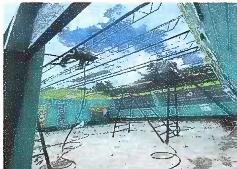
Foto 4: Módulo 1: Instalación de estructura portante de metal
