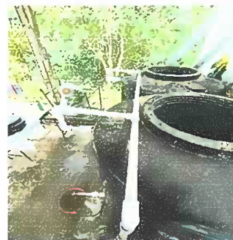
Foto 6: Modulo 2: instalación de tubería principal de pvc para agua potable
