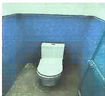
Foto 5: Modulo 2: Sustitución Inodoro
