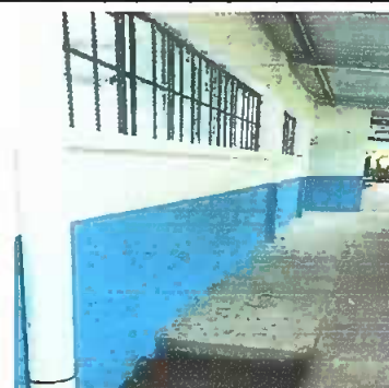
Foto 4: Modulo 1: Pintura en muros exteriores e interiores
