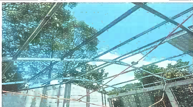
Foto 3: Modulo 1: Instalación de estructura portante de metal
