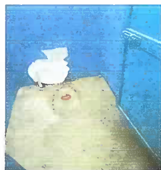
Foto 5: Modulo 2: Sustitución Inodoro
