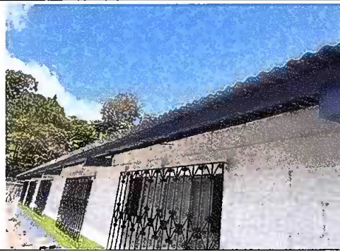
Foto 8: Modulo 4: Sustitución de lámina, por lámina troquelada aluzinc calibre 26
