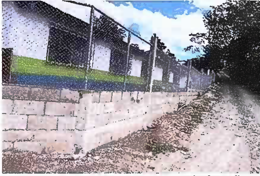
Foto 1: Modulo 1: Reparación de muro perimetral de block con tubo hg y malla galvanizada, soleras intermedias y columnas
