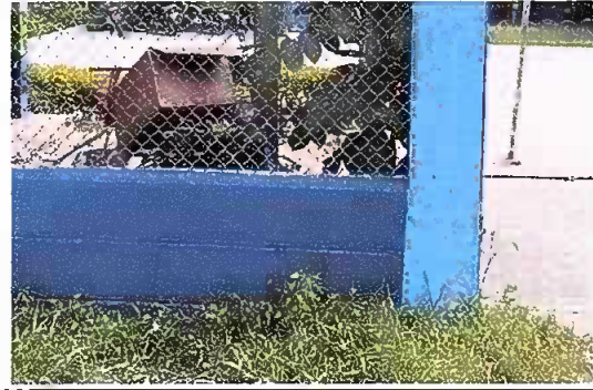
Foto 2: Modulo 1: Pintura en muros exteriores e interiores
