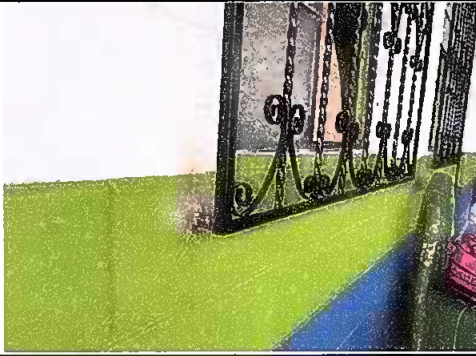
Foto 7: Modulo 4: Mantenimiento a balcones de metal
