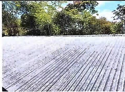
Foto 10: Modulo 4: Instalación de lámina troquelada aluzinc
