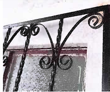
Foto 4: Modulo 2: Mantenimiento a balcones de metal
