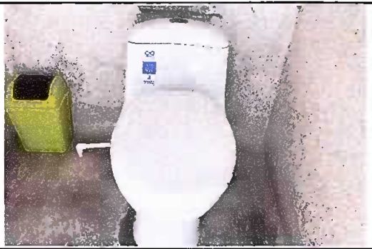
Foto 5: Modulo 3: Sustitución inodoro
