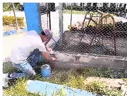
Foto 2: Modulo 1: Pintura en muros exteriores e interiores
