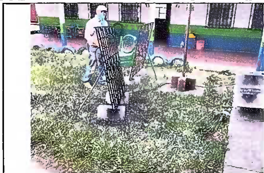
Foto 7: Modulo 4: Mantenimiento a balcones de metal
