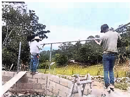
Foto 1: Modulo 1: Reparación de muro perimetral de block con tubo hg y malla galvanizada, soleras intermedias y columnas
