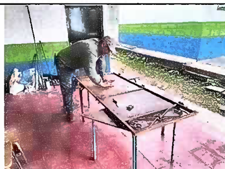
Foto 6: Modulo 3: Mantenimiento a estructura de puerta (lijado, cambio de tubo, cepillado, sujeciones, aplicación de pintura) a puertas servicios sanitarios
