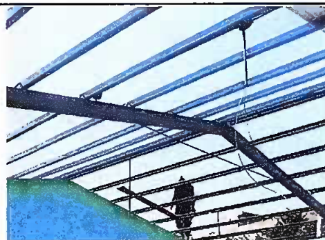
Foto 10: Modulo 4: Instalación de lámina troquelada aluzinc
