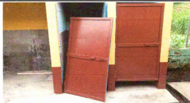
Foto 6: Módulo 3: Mantenimiento a estructura de puerta (lijado, cambio de tubo, cepillado, sujeciones, aplicación de pintura) a puertas servicios sanitarios
