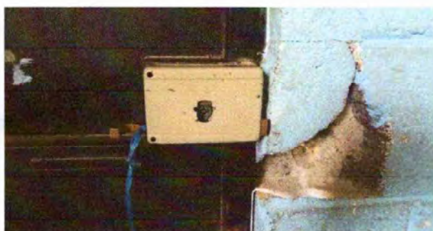
Foto 3: Módulo 2: Mantenimiento a estructura de puerta (lijado, cambio de tubo, cepillado, sujeciones, aplicación de pintura)
