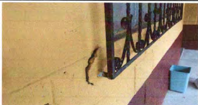
Foto 7: Modulo 4: Mantenimiento a balcones de metal
