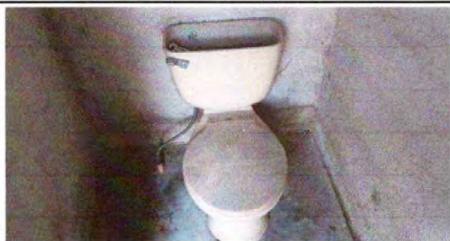
Foto 5: Módulo 3: Sustitución inodoro
