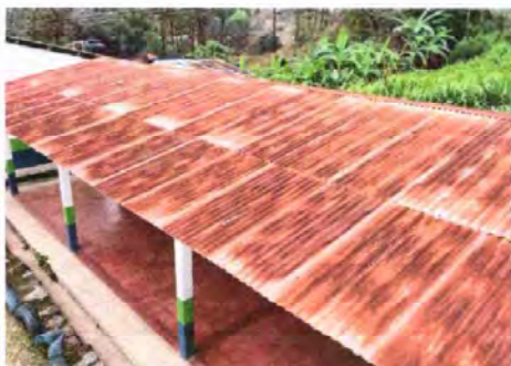
Foto 9: Modulo 4: Sustitución de capote de lámina para lámina troquelada
