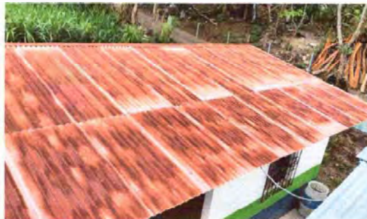
Foto 10: Modulo 4: Instalación de lámina troquelada aluzinc
