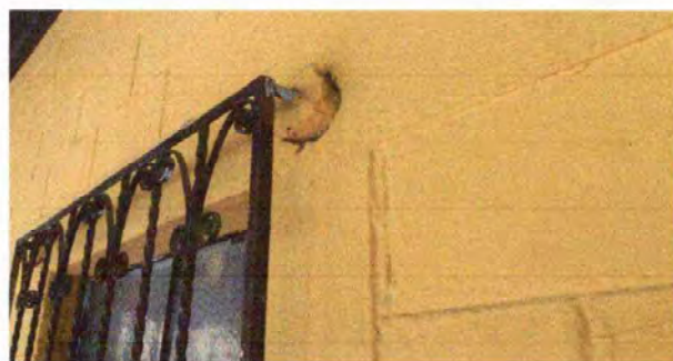
Foto 4: Módulo 2: Mantenimiento a balcones de metal
