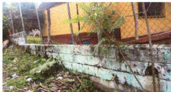
Foto 2: Módulo 1: Pintura en muros exteriores e interiores
