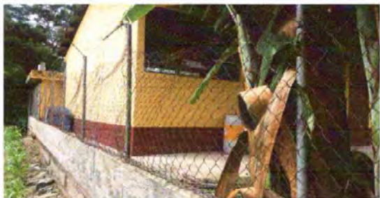
Foto 1: Módulo 1: Reparación de muro perimetral de block con tubo hg y malla galvanizada, soleras intermedias y columnas
