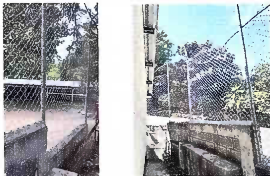
Foto 9: Muro Perimetral: Reparación de muro primetral de block con tubo hg y malla galvanizada , soleras intermedias y columnas
