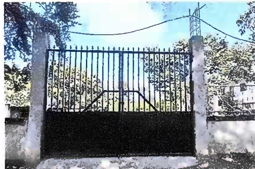
Foto 8: Muro Perimetral: Sustitución de portón (3.40x2.30)
