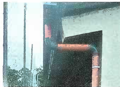
Foto 6: Modulo 2: Sustitución de canal de metal
