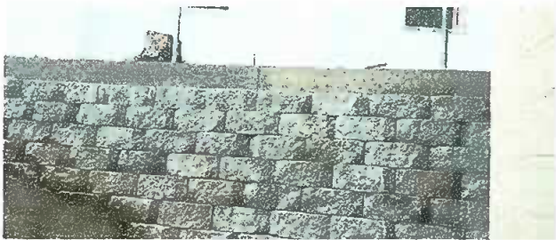
Foto 1: Modulo 1: Reparación de muro de contención
