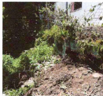
Foto 2: Modulo 1: Reparación de muro de contención
