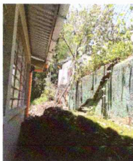
Foto 1: Modulo 1: Reparación de muro de contención
