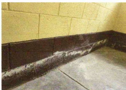
Foto 5: Modulo 2: Cernido en muro
