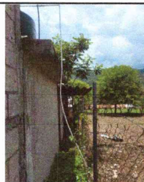
Foto 4: Modulo 1: Reparación de muro perimetral de block con tubo hg y malla galvanizada, soleras intermedias y columnas
