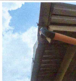
Foto 6: Modulo 2: Sustitución de canal de metal
