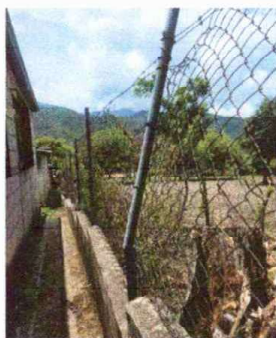
Foto 3: Modulo 1: Reparación de muro perimetral de block con tubo hg y malla galvanizada, soleras intermedias y columnas
