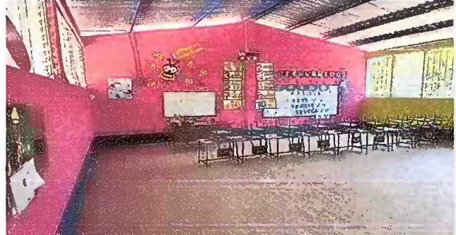
Foto 4: Pintura General: Pintura en muros exteriores e interiores
