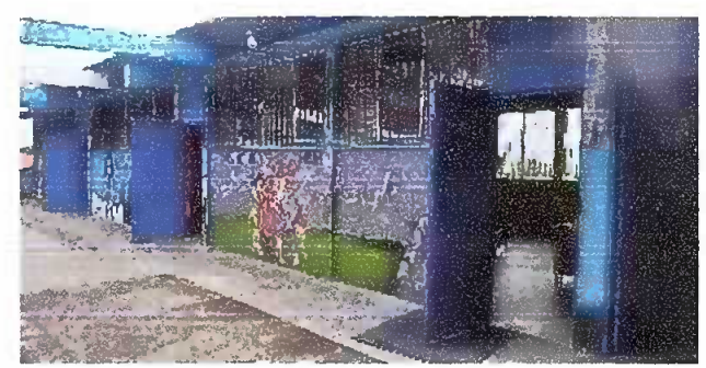
Foto 6: Modulo 2: Mantenimiento a estructura de puerta (lijado, cambio de tubo, cepillado, sujeciones, aplicación de pintura)
