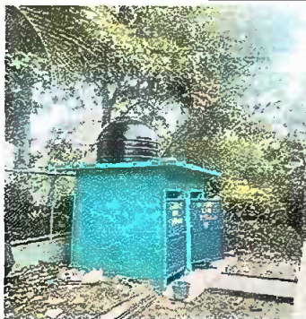
Foto 3: Modulo 9: Sustitución de depósito de agua 1000 lt
