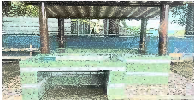
Foto 5: Modulo 2: Sustitución de pila de cemento de un lavadero
