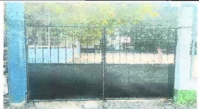
Foto 10: Modulo 3: Sustitución de portón de metal
