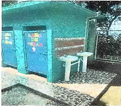
Foto 7: Modulo 7: Sustitución lavamanos
