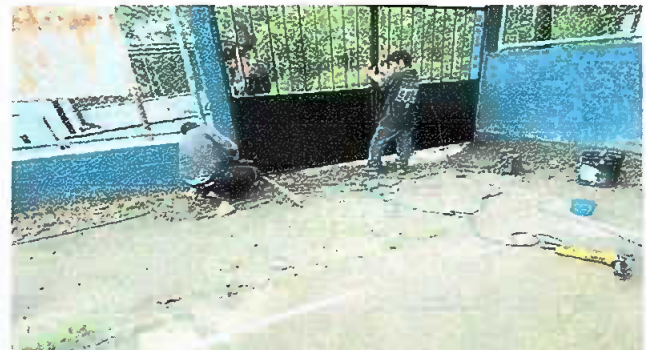
Foto 10: Módulo 3: Sustitución de portón de metal
