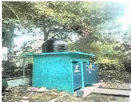
Foto 9: Módulo 9: Sustitución de depósito de agua 1000 lt
