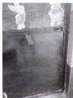
Foto 3: Módulo 1: Sustitución de chapa
