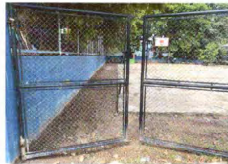
Foto 10: Modulo 3: Sustitución de portón de metal
