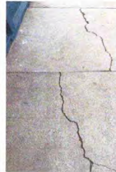
Foto 8: Modulo 2: Sustitución de piso cerámico
