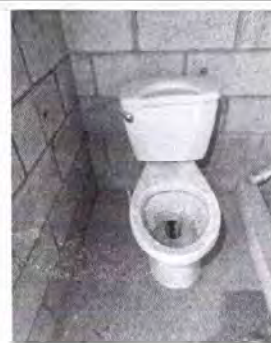
Foto 6: Módulo 2: Sustitución de accesorios inodoro (contra llave, tubo de abasto y tanque)
