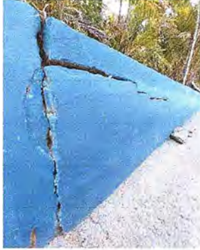
Foto 1: Modulo 1: Reparación de muro de contención
