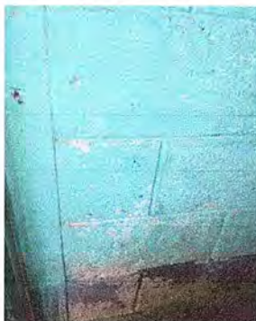
Foto 7: Modulo 3: Pintura en muros exteriores e interiores
