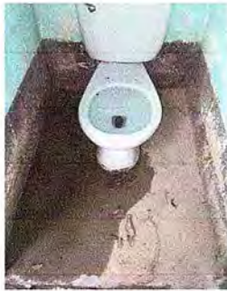
Foto 3: Modulo 2: Sustitución inodoro
