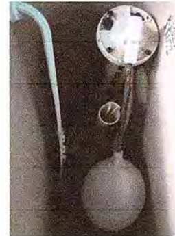
Foto 4: Modulo 2: Instalación de inodoro
