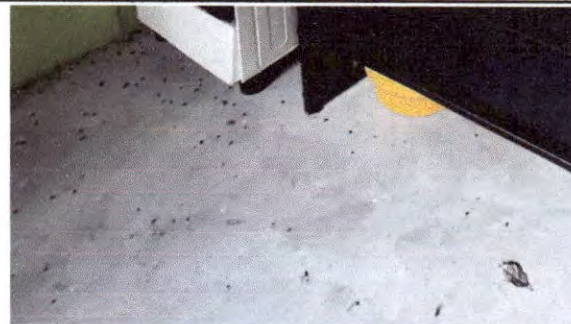
Foto 4: PISO ACTUAL EN CONDICIONES PARA INSTALACION DE PISO CERAMICO ANTIDESLIZANTE.
