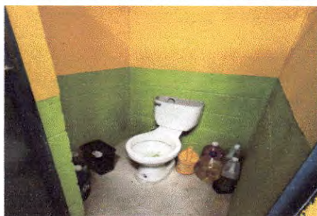
Foto 5: SANITARIO CON TANQUE RAJADO Y SIN TAPADERA.
