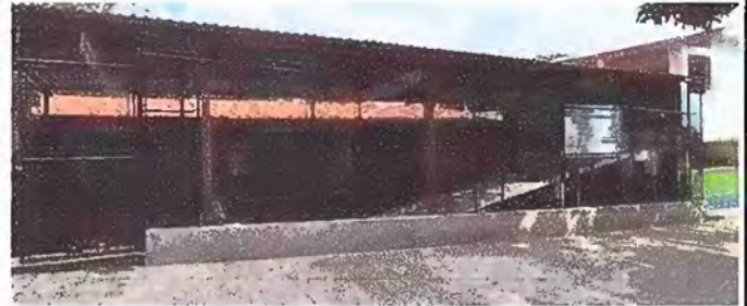
Foto 14: MURO PERIMETRAL: Reparación de muro perimetral de block con tubo hg y malla galvanizada, soleras intermedias y columnas
