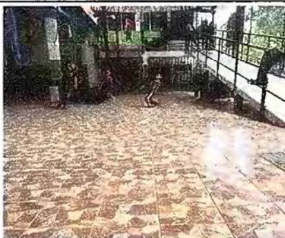
Foto 5: Módulo 2: Sustitución de piso de torta de concreto por piso cerámico
