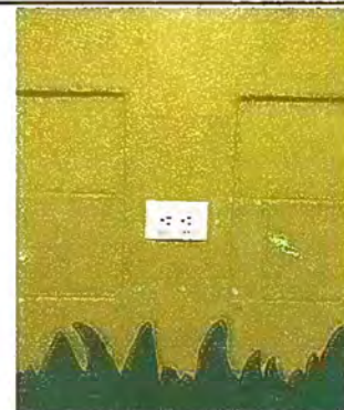
Foto 8: Modulo 2: Sustitución de tomacorrientes dobles
