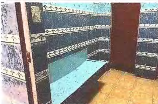
Foto 12: Modulo 3: Sustitución de azulejo
