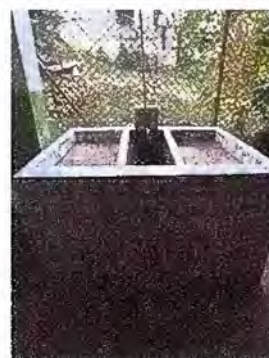
Foto 4: Módulo 2: Sustitución de pila por pila de concreto insitu
