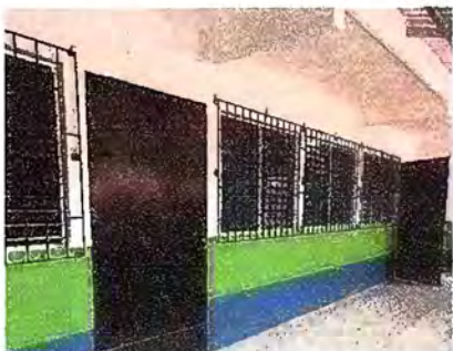
Foto 1: Módulo 1: Suministro e instalacion de balcones de metal
