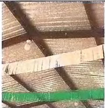
Foto 9: Modulo 2: Sustitución de focos ahorradores
