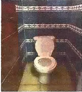
Foto 13: Modulo 3: Sustitución de accesorios inodoro (contra llave, tubo de abasto y tanque)
