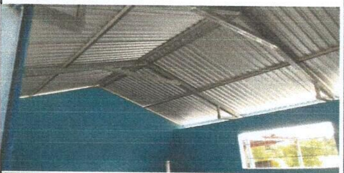
Foto 5: Sustitución de lámina por lámina troquelada aluzinc cal. 26
