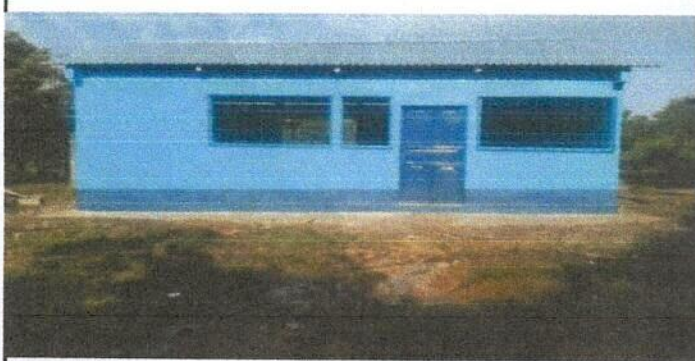
Foto1: Aplicación de pintura en paredes internas y externas
