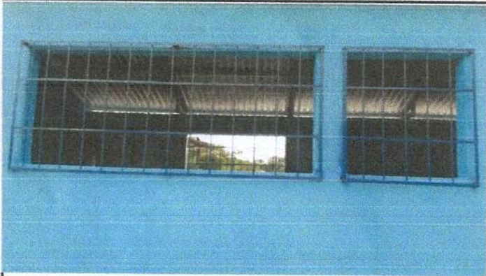
Foto 3: Sustitución de ventanas de madera por balcones de metal
