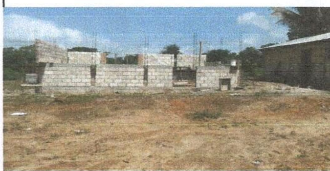
Foto 4: seguimiento de columnas y paredes de la cocina escolar
