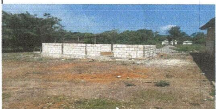
Foto 3: Levantado de columnas y paredes de la cocina escolar
