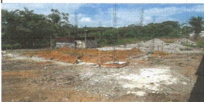
Foto 1: Inicio de reparación de la cocina escolar
