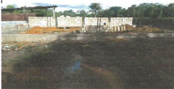
Foto 2: Levantado de paredes de la cocina escolar
