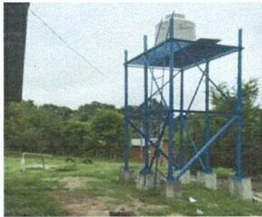
Foto 3: Torre con tinaco terminado
