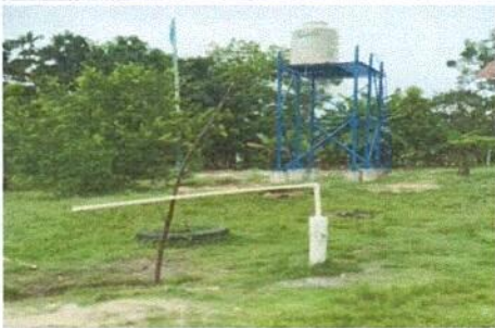
Foto 5: Pozo y torre metalica para el suministro de agua.
