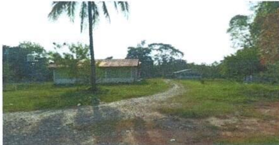
Foto 1: Ubicación de pozo terminado en el area del establecimiento.
