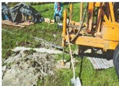
Foto 3: Máquina trabajando en la perforación del pozo
