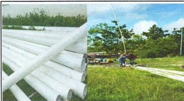
Foto 4: Tubería del pozo e ingreso de los mismos en la perforación
