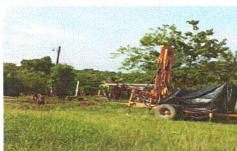
Foto 2: Maquinaria llegando para la perforación del pozo
