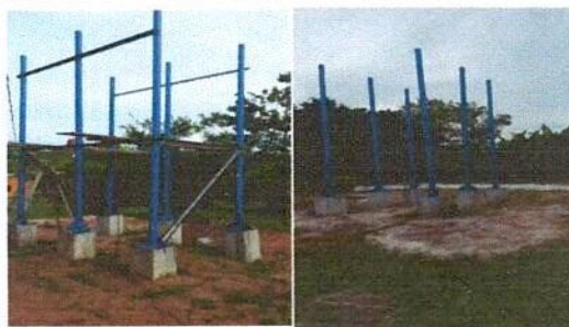
Foto 6: Instalación de torre metálica para deposito de agua.
