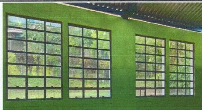
Foto 2: Mantenimiento a estructura de metal de ventana
