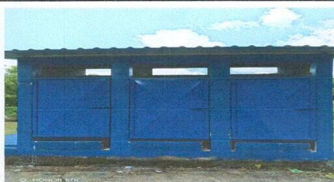
Foto 4: Mantenimiento a estructura, aplicación de pintura a puertas de sanitarios
