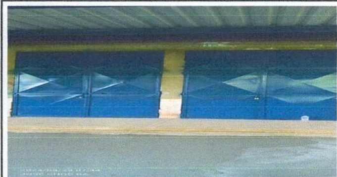
Foto 3: Sustitución de puerta metal por metal
