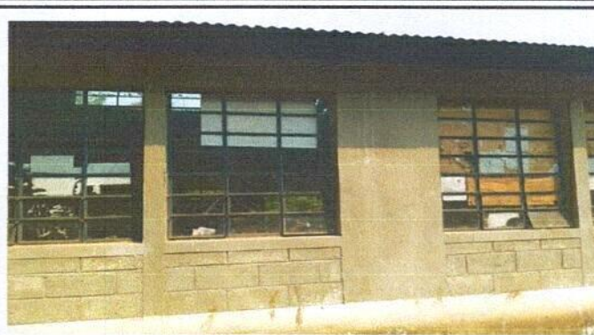
Foto 2: Mantenimiento a estructura de metal de ventana
