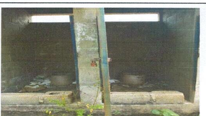
Foto 4: Mantenimiento a estructura, aplicación de pintura a puertas de sanitarios
