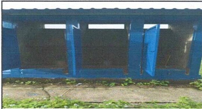
Foto 7: Sustitución de inodoro
