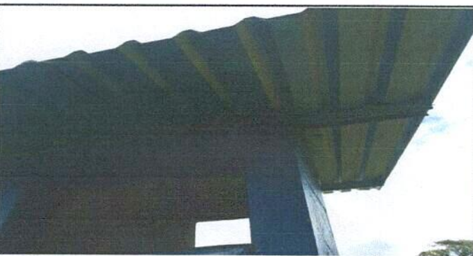
Foto 5: Sustrucción de lámina, por lámina troquelada aluzinc calibre 26
