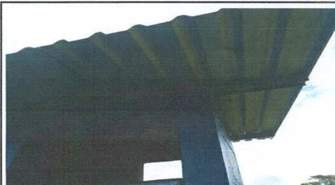
Foto 8. Sustitución de estructura de soporte de madera, por metal
