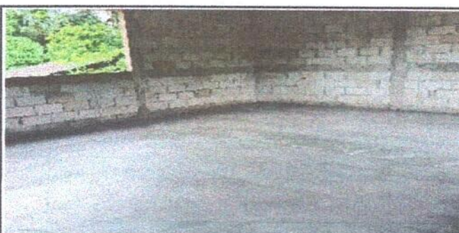
Foto 6: Piso de torta de concreto
