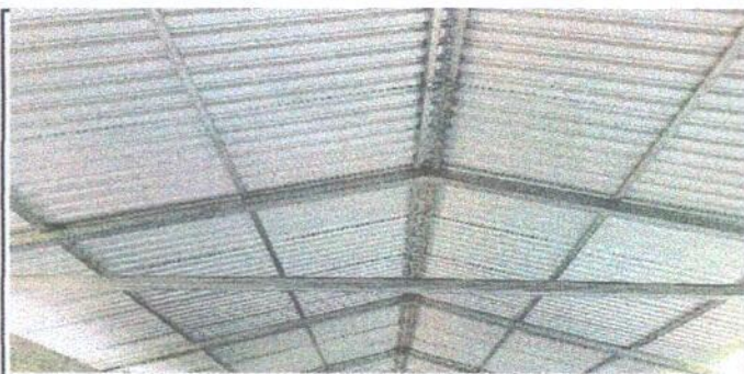
Foto 3: Sustitución de estructura de madera por metal
