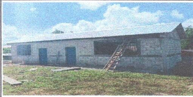
Foto 2: Sustitución de capote por lámina troquelada
