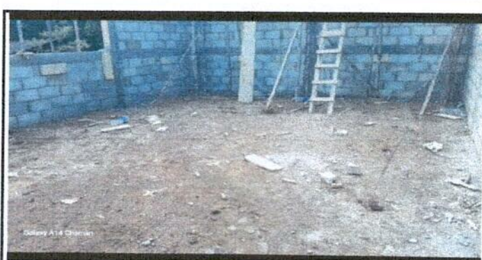
Foto 6: Piso de torta de concreto
