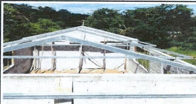
Foto 3: Sustitución de estructura de madera por metal
