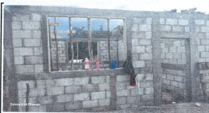
Foto 5: Instalación de balcones de metal
