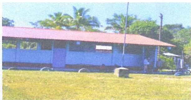
Foto1: Sustitución de láminas en todo el modulo 1.
