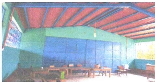
Foto 2: finalizacion de mantenimiento a estructura de la EODP ANEXA A EORM.
