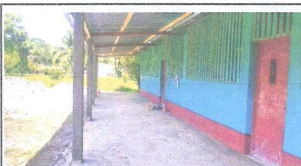
Foto 6: Finalizacion del repello y pintada de la pared de EORM.
