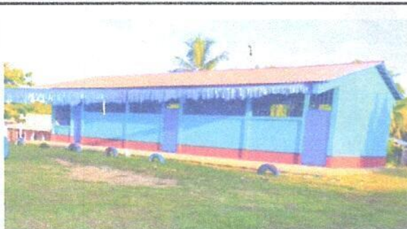
Foto 4: De esta manera queda concluido las puertas instaladas en la EODP ANEXA EORM.
