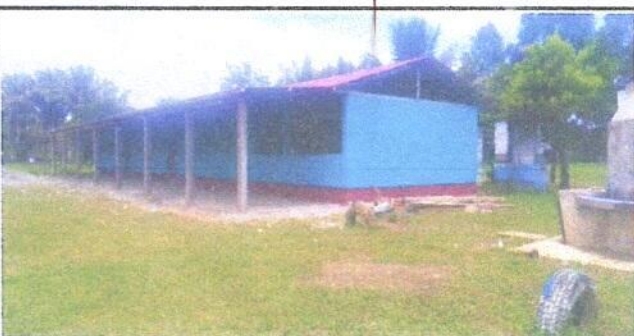
Foto 5: finalizacion del corredor de la EORM .
