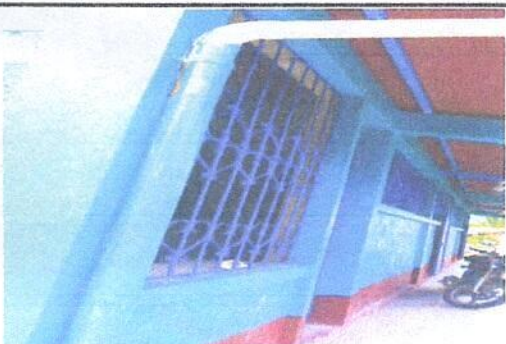
Foto 3: finalizacion de las ventanas de balcon.
