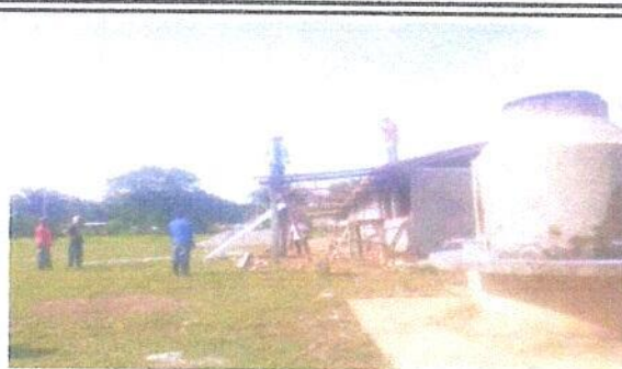
Foto 1: Proceso de mantenimiento a estructura de la EODP ANEXA EORM.
