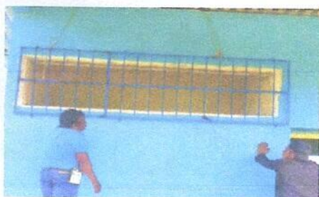
Foto 3: Momento de la instalación de balcones en la EODP ANEXA EORM.
