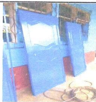
Foto 4: Instalación de puertas en la EODP ANEXA EORM.
