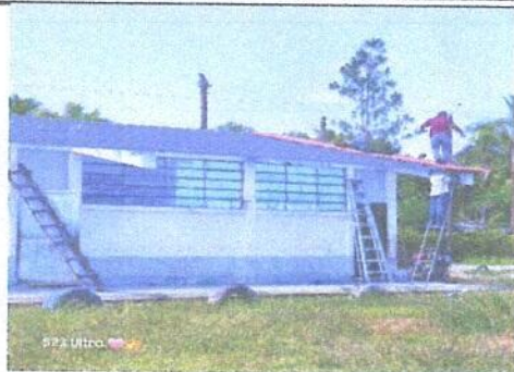
Foto1: techado de laminas de la EORM.
