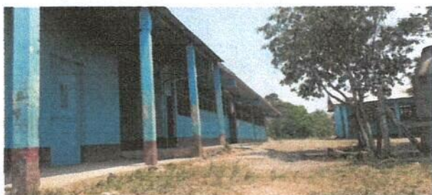
Foto 3: vista de perfil de aulas
