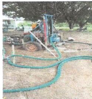
Foto 4: Vista de pozo
