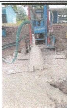
Foto 5: Ubicación del pozo
