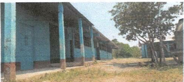
Foto 3: Vista de perfil de aulas y biblioteca
