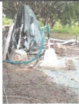
Foto 6: Vista interior del pozo
