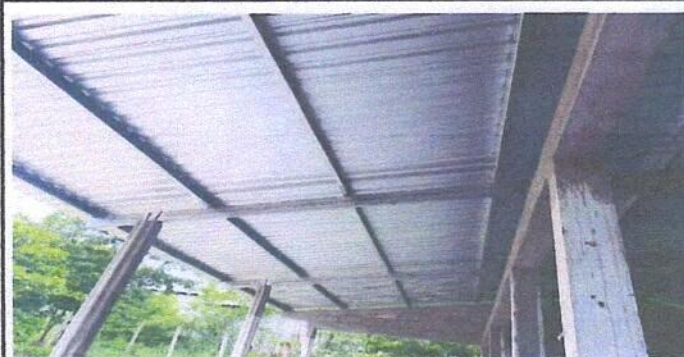
Foto 3: Sustitución de estructura de madera por metal, corredor
