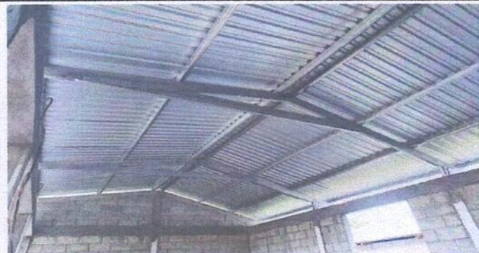
Foto 2: Sustitución de estructura de madera por metal
