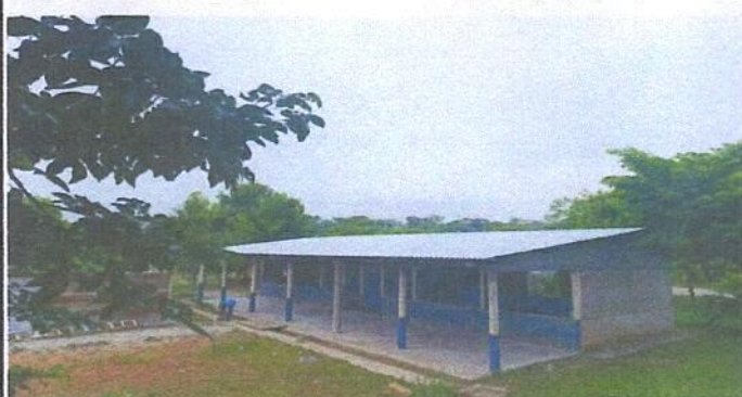
Foto1: Cambio de lámina por lámina troquelada
