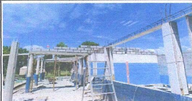
Foto 3: Sustrucción de estructura de madera por metal, corredor
