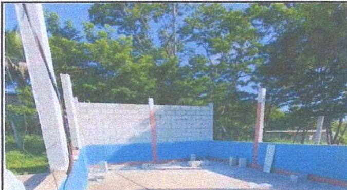
Foto 2: Sustrucción de estructura de madera por metal
