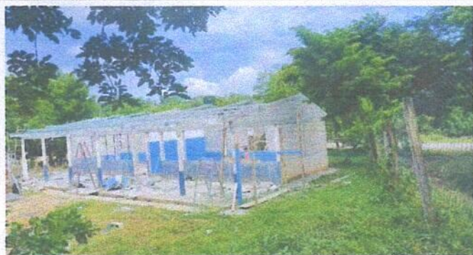
Foto 1: Sustrucción de lámina por lamina troquelada
