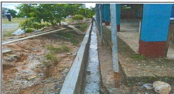
Foto 6: Cuneta de concreto 3 aulas terminada .
