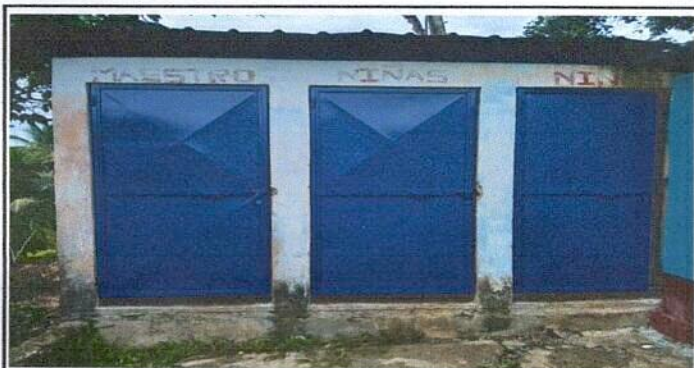
Foto 5: Instalacion de 3 puertas para letrina abonera
