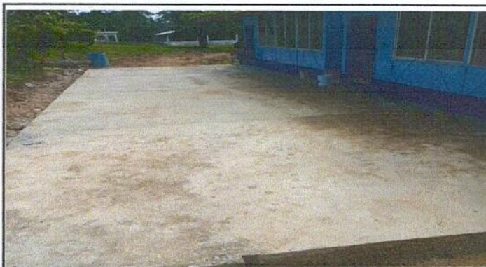
Foto 3: Losa de patio finalizada
