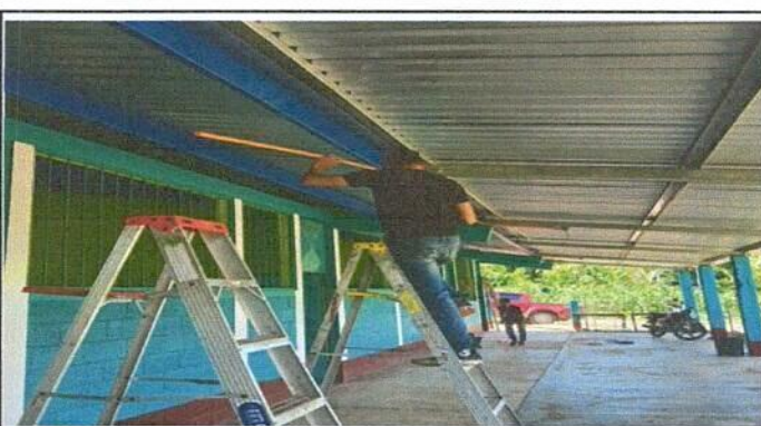
Foto 4: Electricista realizando la instalacion correspondiente
