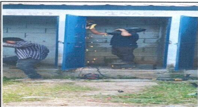
Foto 5: Instalación de puertas para letrina abonera.
