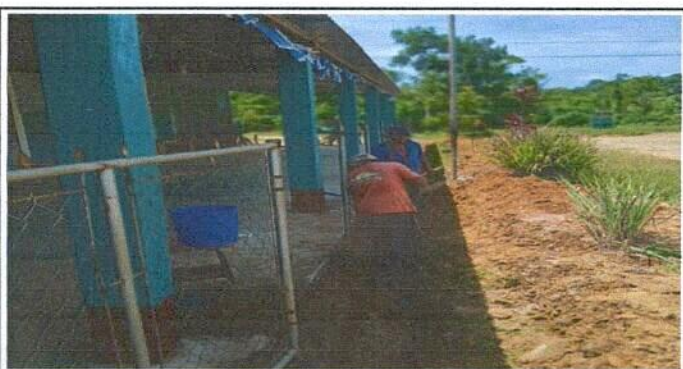
Foto 6: Sangeo para cuneta de concreto
