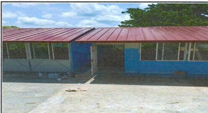
Foto1: Avanse en el proceso de pintada
