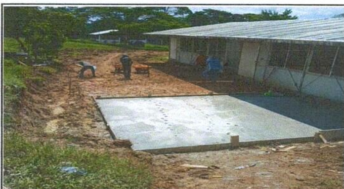
Foto 3: Primera cuarta parte losa de patio
