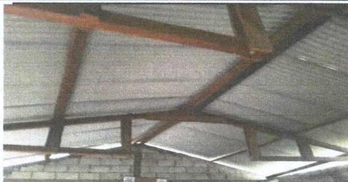
Foto 2: techo de la cocina a sustituir
