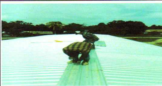
Foto 1: Finalizacion del techado de la escuela
