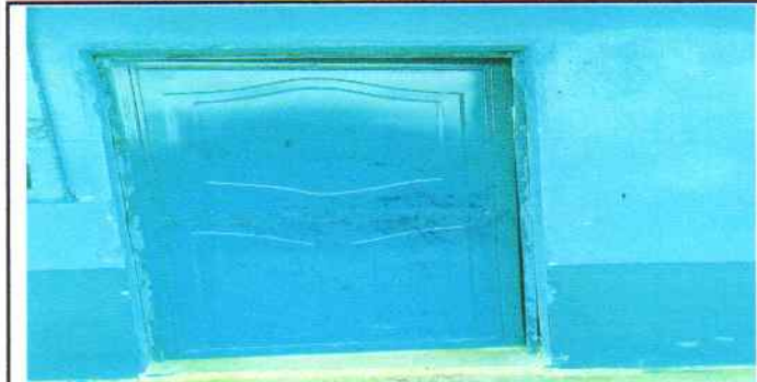
Foto 6: Puestas de metal colocadas
