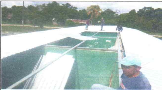
Foto 3: Colocacion de lamina
