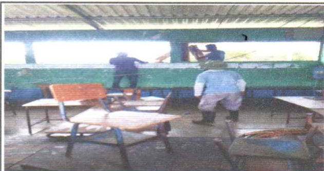
Foto 5: Colocaciones de balcones de metal
