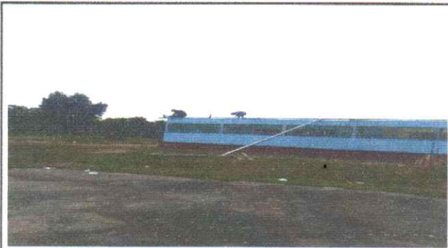
Foto 2: Colocaion de costaneras de metal
