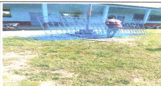
Foto 6: Mantenimientos de balcones
