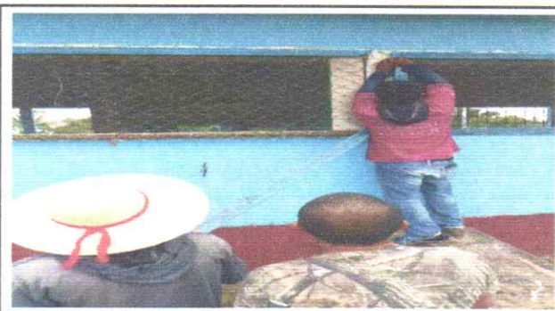
Foto 4: Retiro de maya por balcones de metal
