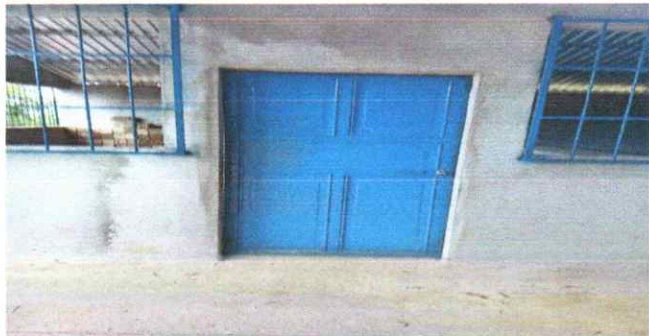
Foto1: Vista colocacion de puertas.
