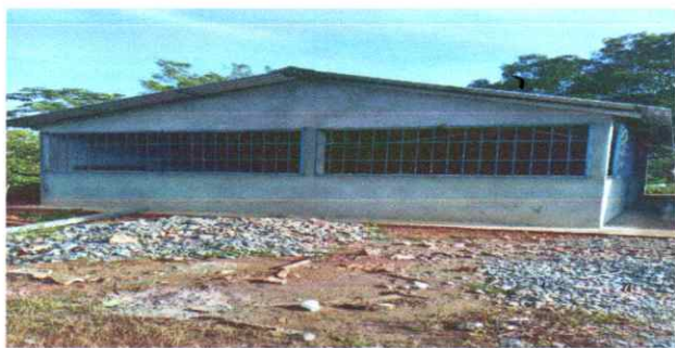
Foto 5: Vista finalizacion de estructura.
