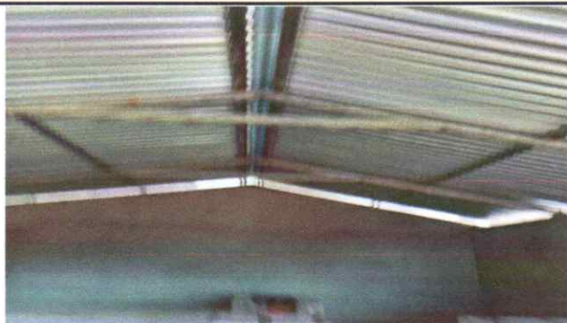
Foto 3: Vista colocacion de lamina.
