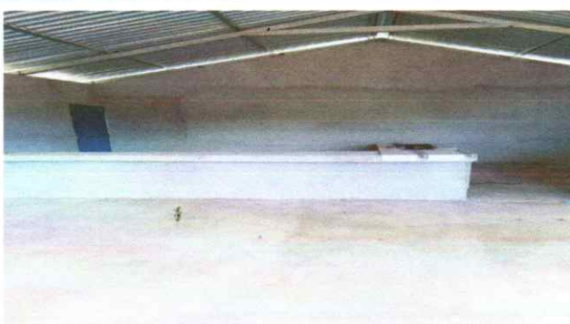
Foto 4: Vista terminacion de piso.
