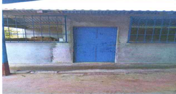
Foto 6: Vista colocacion de puerta.
