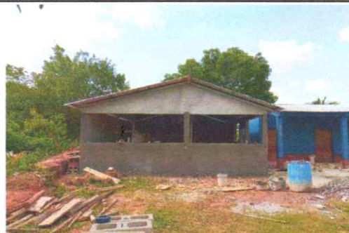
Foto 4: Vista finalizacion de repellado.
