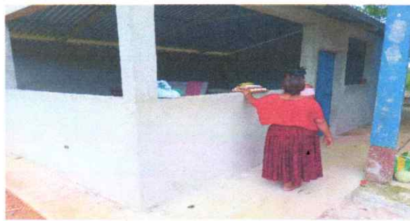
Foto 2: vista acabado de repello.
