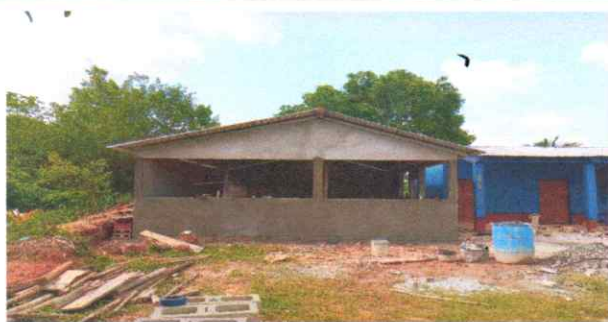
Foto 5: Vista finalizacion de detalles.
