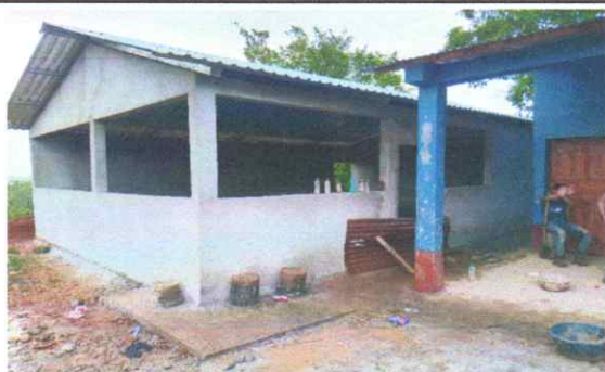
Foto 3: Vista inicio de acera.
