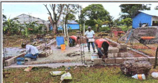
Foto 2: Parte culata lado Norte. 13/08/2024
