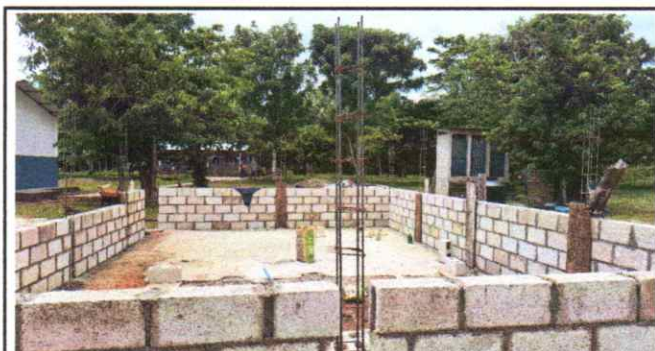
Foto 3: Parte culata lado Norte. 15/08/2024
