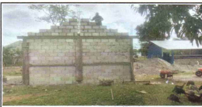
Foto 6: Parte culata lado Norte. 26/08/2024
