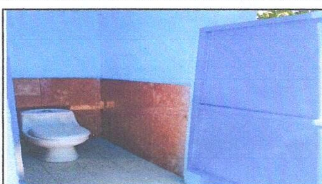
Foto 4: sustitución de inodoro
