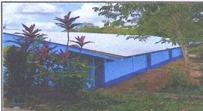
foto1: Sustitución de lámina, por lámina troquelada aluzinc calibre 26, del modulo 2.
