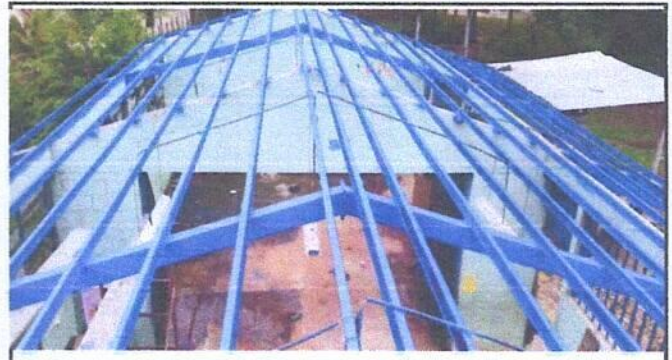
Foto 2: Mantenimiento a estructura de soporte de metal por daños de óxido.
