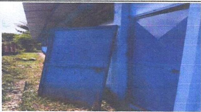
Foto 3: sustitución de puerta
