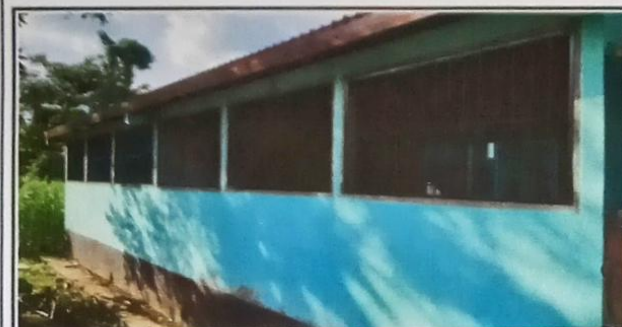
Foto 3: Colocación de balcones, parte de atrás.
