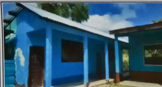
Foto 1: Colocación cubierta de lámina.
