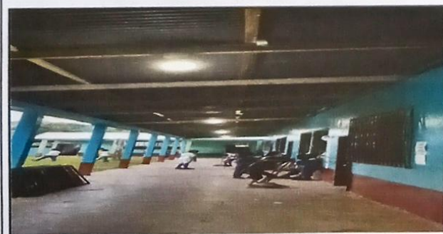
Foto 5: Instalación de cableado eléctrico.
