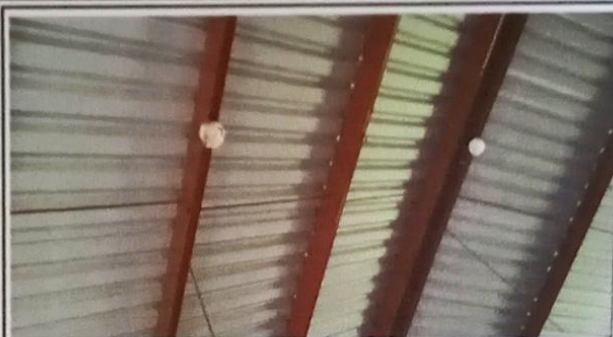
Foto 2: Mantenimiento estructura de metal.
