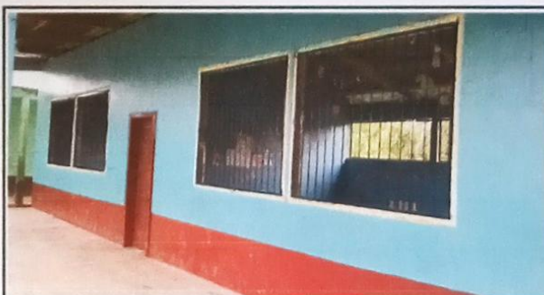
Foto 4: Colocación de balcones, parte frontal.
