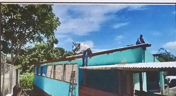
Foto 4: Sustitución de elemento de fijación.
