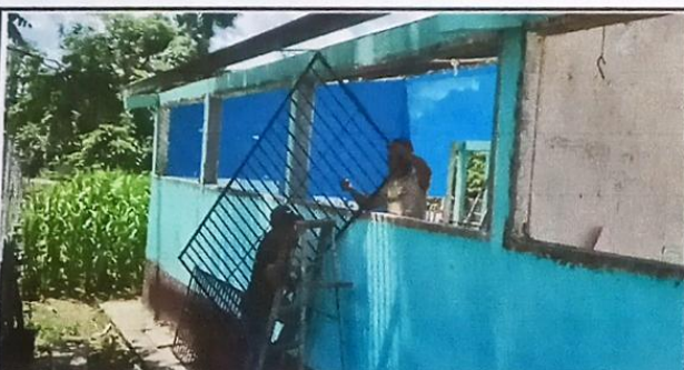
Foto 5: Colocación de balcones de metal.
