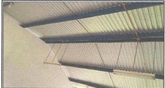
Foto 2: Mantenimiento a estructura de soporte de metal
