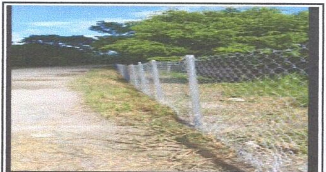
Foto 4: Reparación de muro perimetral de malla con tubo hg y malla galvanizada
