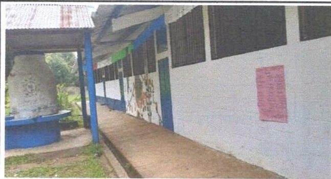
Foto 3: Pintura en muros interiores y exteriores
