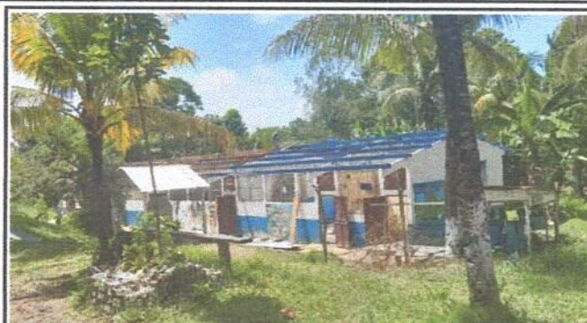
Foto 2: Mantenimiento a estructura de soporte de metal
