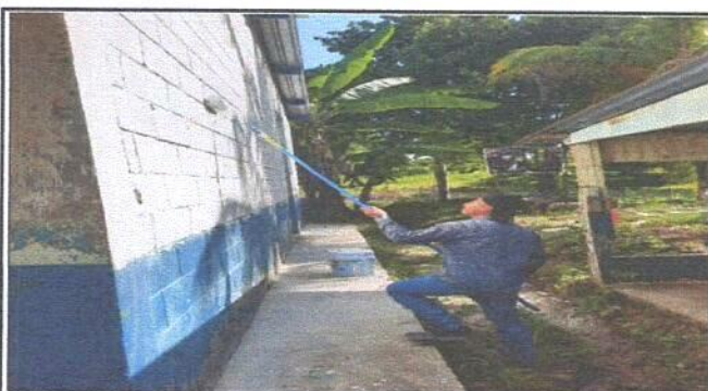
Foto 3: Pintura en muros interiores y exteriores
