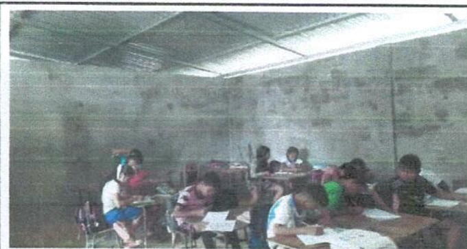
Foto 5: Repello en muro del centro educativo.
