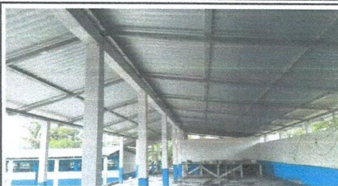
Foto 2: Sustitución de estructura de madera por metal
