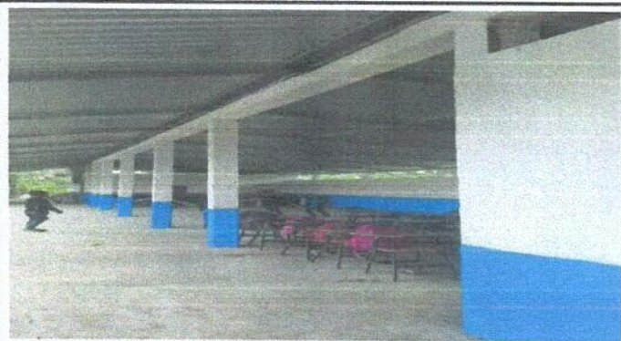
Foto 1: Sustitución de cubierta lámina por lámina troquelada
