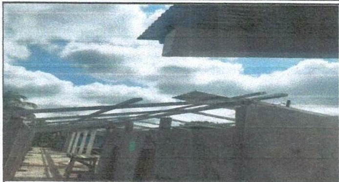
Foto 1: Sustrucción de cubierta lámina por lámina troquelada
