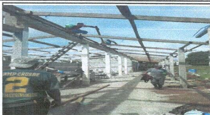
Foto 2: Sustrucción de estructura de madera por metal
