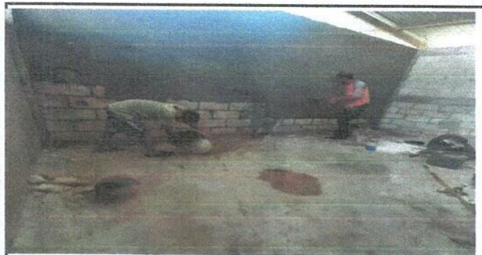
Foto 5: Repello en muro del centro educativo.
