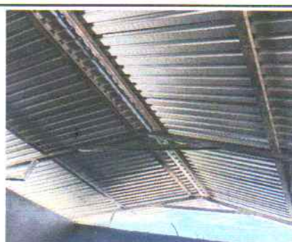
Foto 4: cubierta total de techo de cocina, con estructura de metal y lamina troquelada aluzinc completo con capote.
