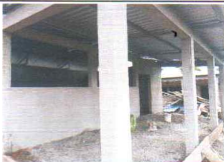
Foto 5: Trabajo completo realizado de repello de paredes y columnas de concreto de cocina.
