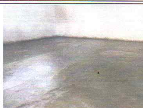
Foto 2: Trabajo culminado y satisfactorio de torta de concreto, de piso de cocina.
