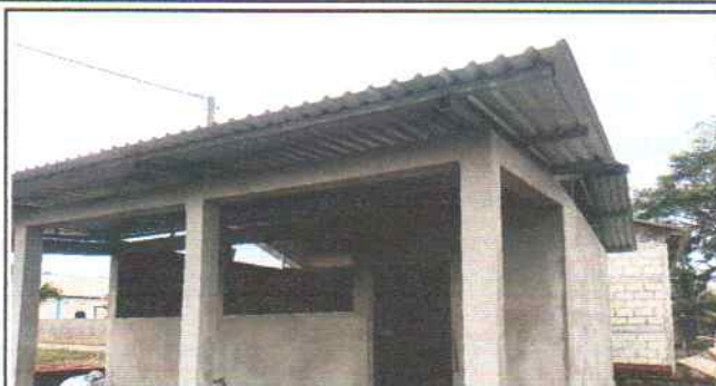
Foto 1: Situación final de construcción de modulo para uso de cocina de EORM Las Flores.
