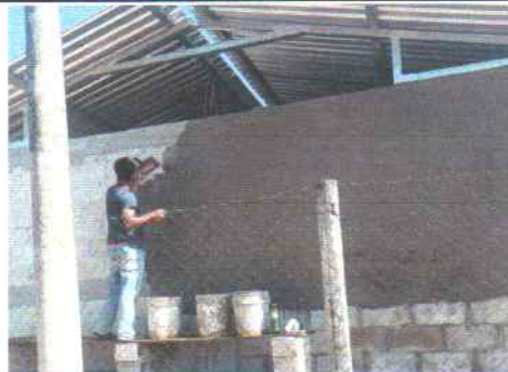
Foto 6: Repello de paredes y columnas en concreto de cocina.
