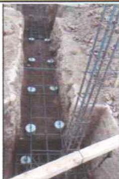
Foto 1: Cimentación y comienzo de construcción de muro para paredes en cocina.
