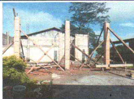
Foto 2: Construcción de paredes en cocina.
