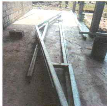
Foto 4: Elaboración de armadura de techo de metal en cocina.
