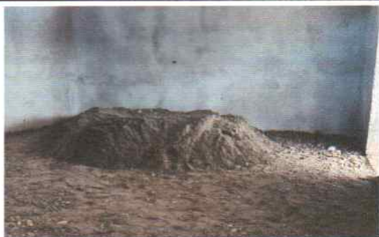
Foto 3: Momento de Construcción de torta de piso de concreto en cocina
