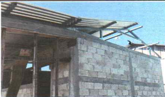
Foto 5: Colocación y fijación de lamina troquelada aluzinc y capote en cocina.
